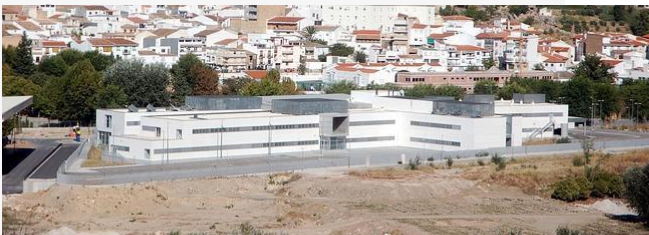
Vista general del hospital de Loja. :: CHAPA
