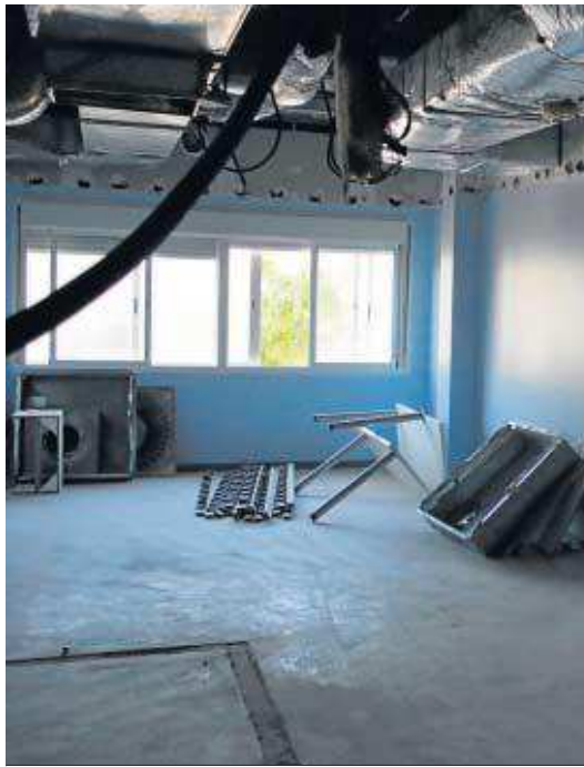
Trauma se está terminando de readaptar de nuevo a sus antiguos servicios.
