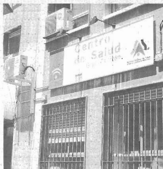
El edificio evidencia el paso del tiempo. :: N.S.L.
