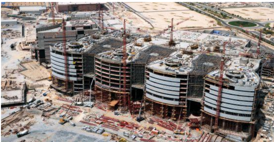
Obras de construcción del nuevo hospital de Doha, en Catar.
