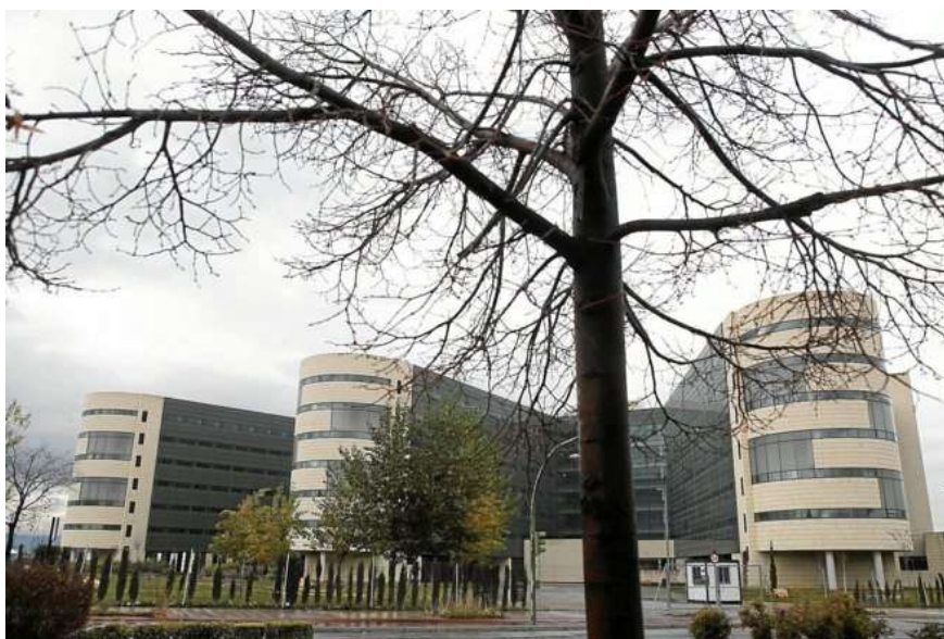
Instalaciones del nuevo Hospital Clínico de Granada. M.RODRÍGUEZ
