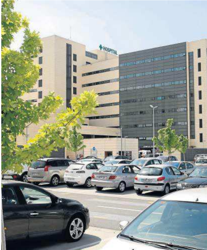
El Hospital del Campus espera liberar espacio para ubicar los servicios que aún se prestan en el antiguo Clínico.
