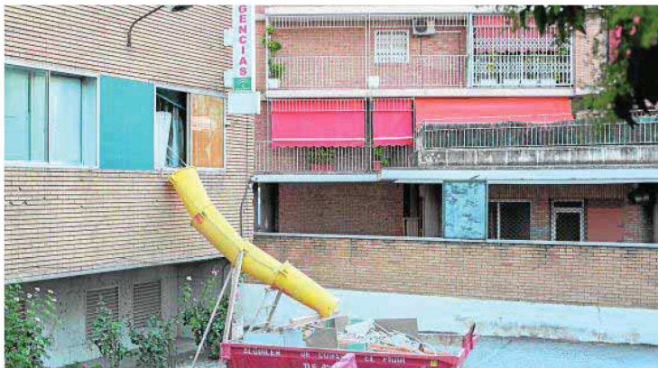
Obras en el centro de salud del Zaidín Este. :: ALFREDO AGUILAR
